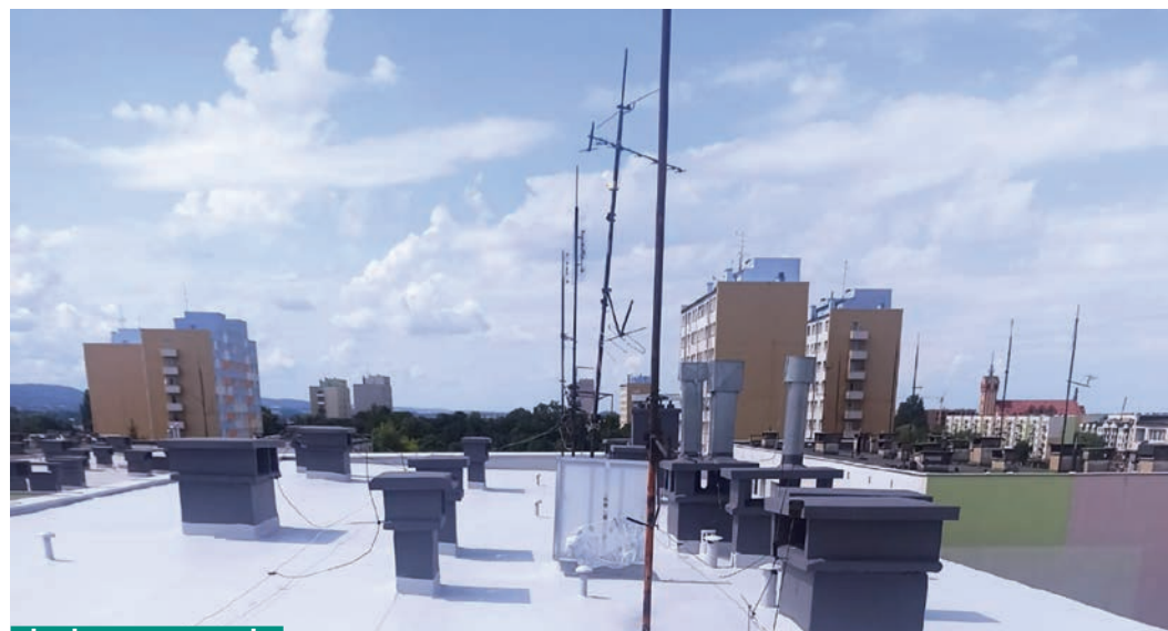
dach po remoncie
